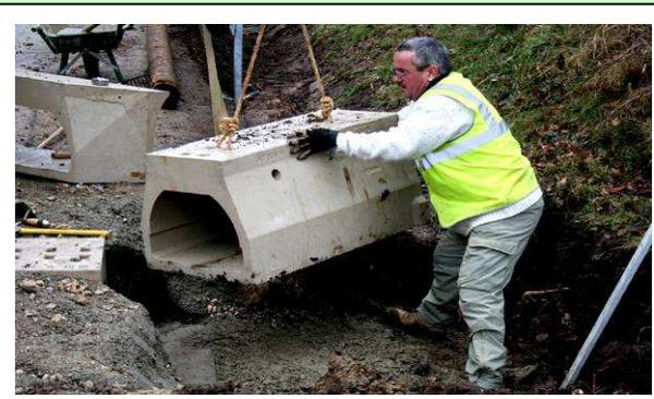
Le « *batracoduc* » permettant la circulation des Batraciens sous la route, est constitué de blocs de béton polyester de 1m de long, assemblés les uns aux autres : des « acodrains », spécialement conçus pour le passage des amphibiens, avec en particulier un fond plat non abrasif.
