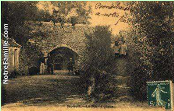
Septeuil, le four à chaux
