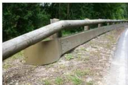
**Ces glissières se transforment aisément en barrage à Batraciens, dès lors que le tablier métallique vertical est enterré et ne laisse aucun espace au sol**
