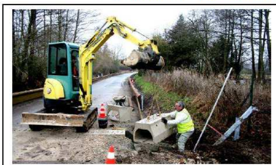
De chaque côté du tunnel, un élément de raccordement évasé facilite l'entrée/sortie de la faune
