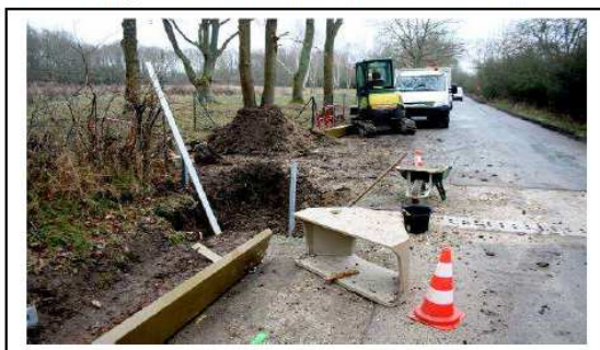
La conduite sous la route relie les fossés situés derrière les glissières
