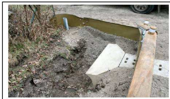
La conduite sous la route relie les fossés situés derrière les glissières
