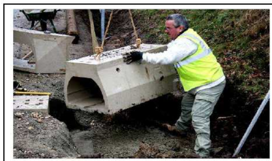
De chaque côté du tunnel, un élément de raccordement évasé facilite l'entrée/sortie de la faune
