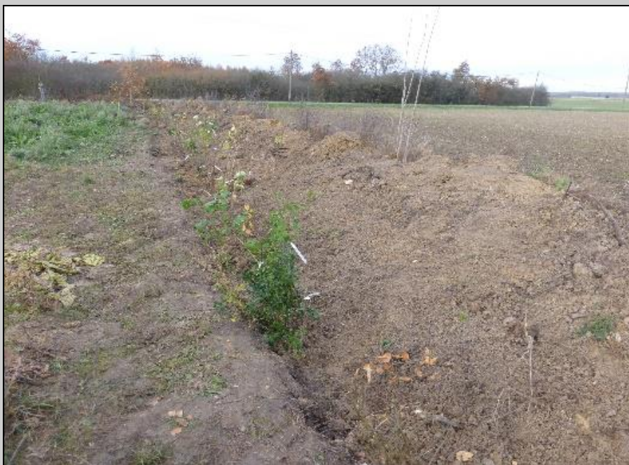
Vue sur la tranchée accueillant la nouvelle haie plantée par les élèves de l'école.
