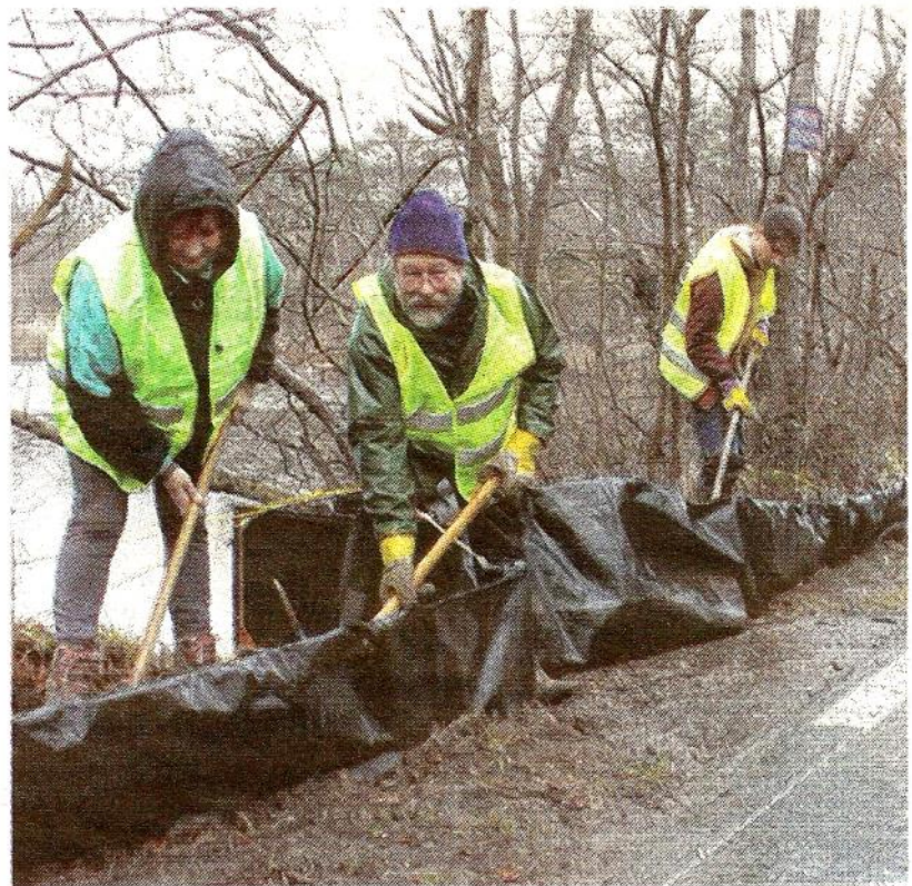
Les bénévoles de l'association Atena, en pleine construction du batracodrome.
