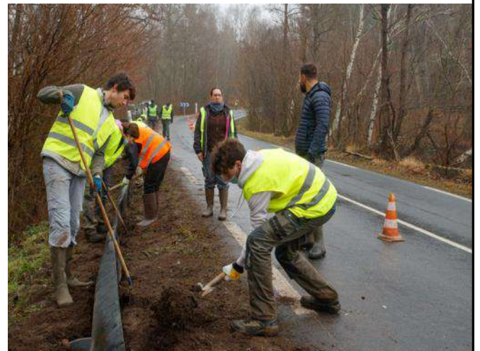
Les piquets, plantés tous les 4m, permettent de tendre la corde supportant la bâche, celle-ci à son tour enterrée solidement.
