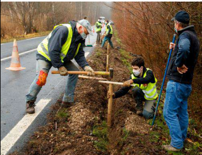
Les piquets, plantés tous les 4m, permettent de tendre la corde supportant la bâche, celle-ci à son tour enterrée solidement.
