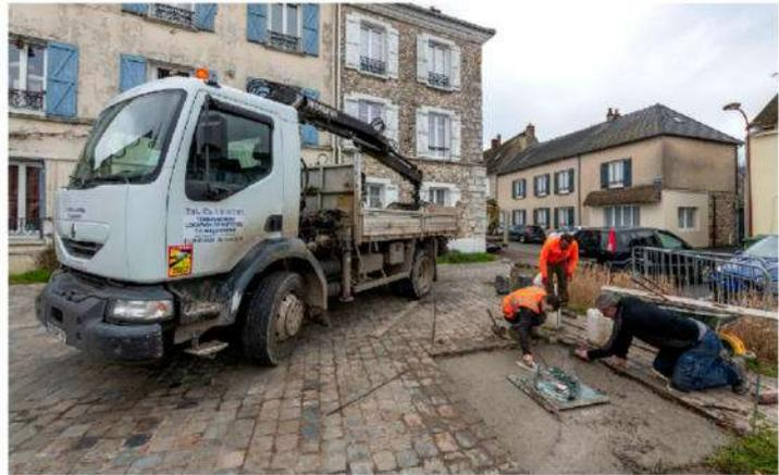
Une fois le trou rempli de béton, la plaque a été soigneusement mise de niveau pour que les tiges soient verticales, en attente de la platine de la tour qui sera boulonnée.
