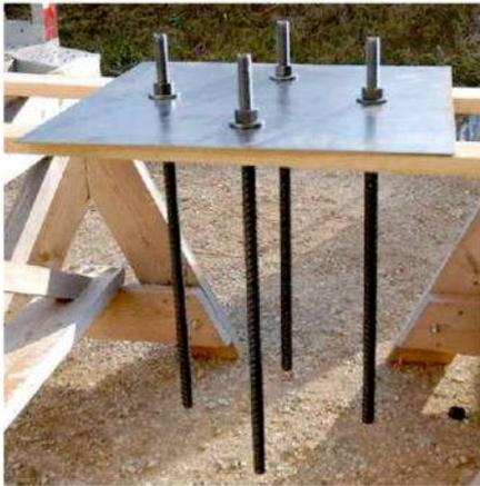
A l'atelier, la plaque servant de guide avec ses gros fers à béton de 80 cm surmontés de leur partie fileté.
