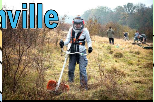
Novembre 2017, travaux de débroussaillage avec le CHEP
