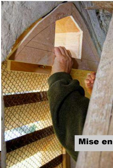
Mise en place et fixation du tube d'entrée
