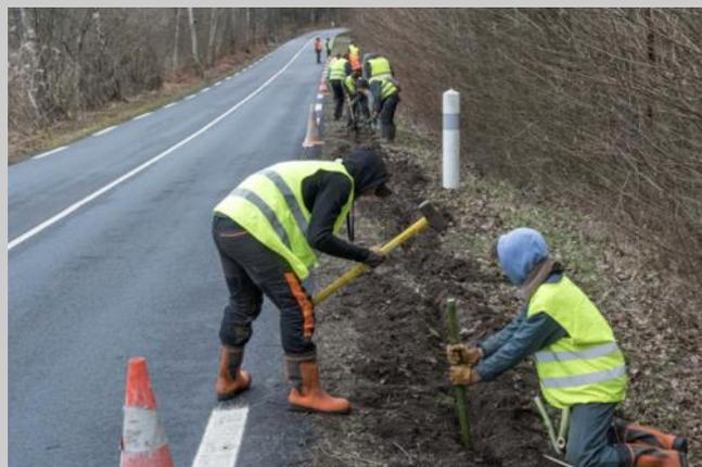
Un avant trou à la barre à mine permet d'enfoncer ensuite facilement (et délicatement) le piquet à la masse.
