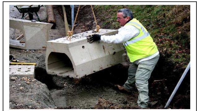
De chaque côté du tunnel, un élément de raccordement évasé facilite l'entrée/sortie de la faune
