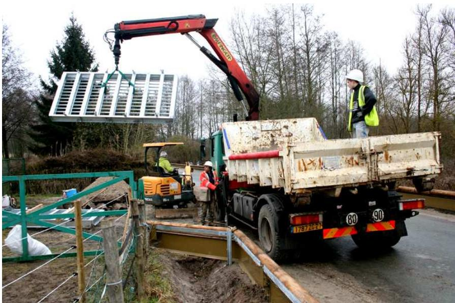
Un fossé de 10m de long par 2m de large a été creusé à la mini pelle face à la grande entrée, puis bétonné et aménagé en caniveau pour y recevoir les grilles.
